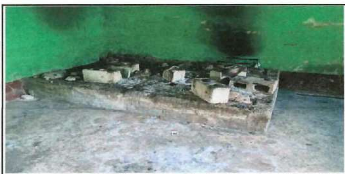
Foto 5: Se observa la necesidad de la sustitucion de estufa rural (completa) incluye chimenea y plancha de metal.
